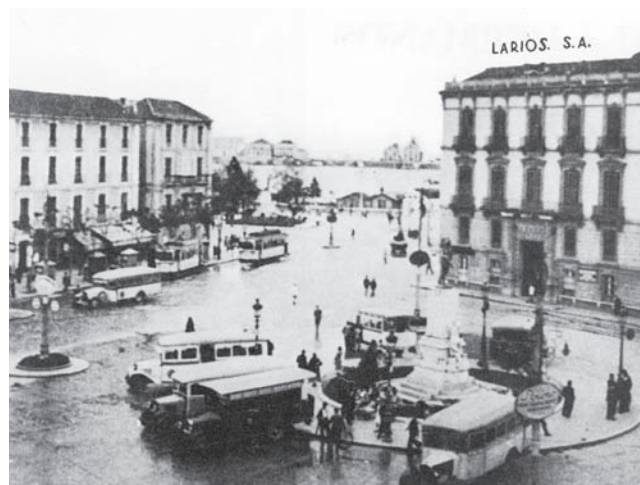
Sede de la Casa Larios, al comienzo de la Alameda
